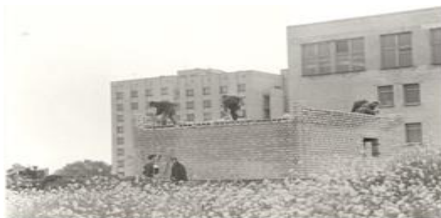
Студенты отделения ПГС группы Валентины Ивановны Комаровой на практике по профессии штукатур. Устройство стяжки на кровле здания.
